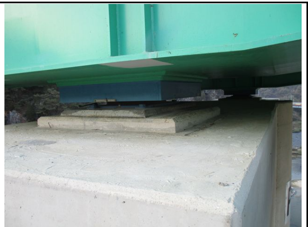
교량받침 P2-SH2 전경
