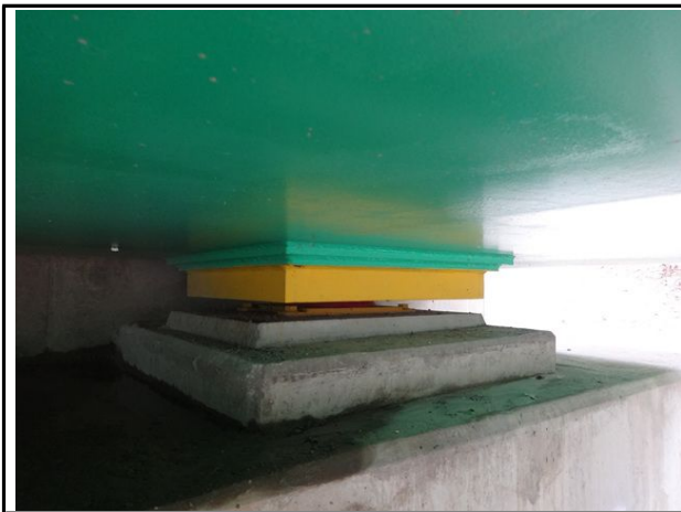
교량받침 A1-SH1 전경
