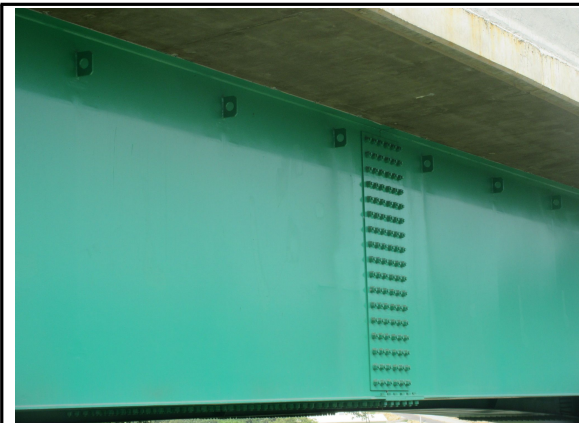
BOX 외부 시공 상태 점검
