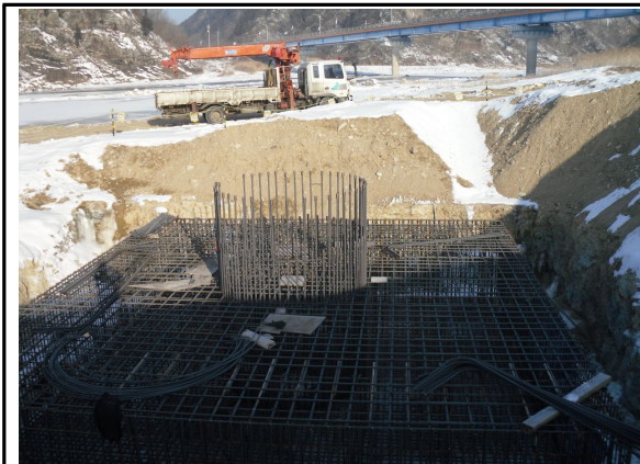
P3 기초 전경
