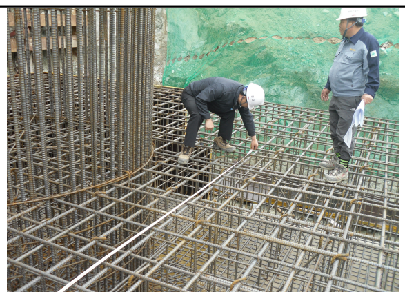
P4 기초 철근 조립 상태
