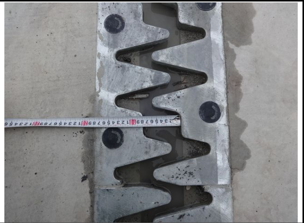
신축이음 A1 유간 측정
