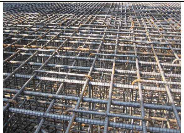
P3 기초 철근 배근 간격
