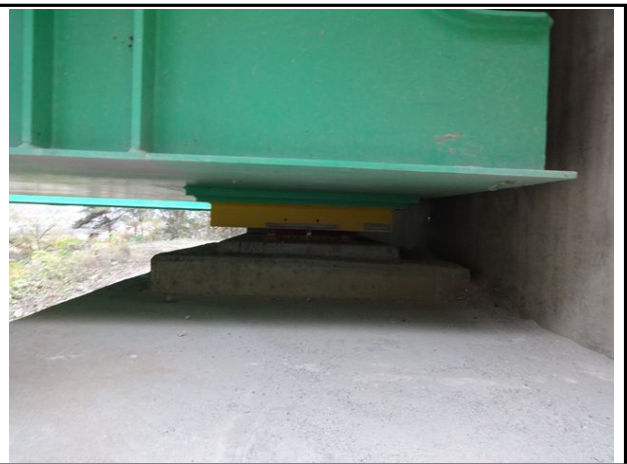
교량받침 A1-SH1 전경
