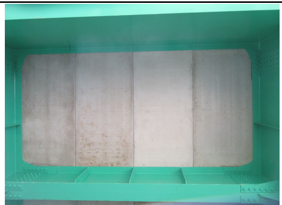
바닥판 하면(LB-DECK) 시공 상태 점검
