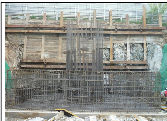
P4 기초 전경
