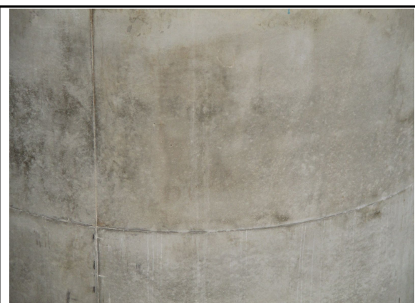
P1 교각 시공 상태
