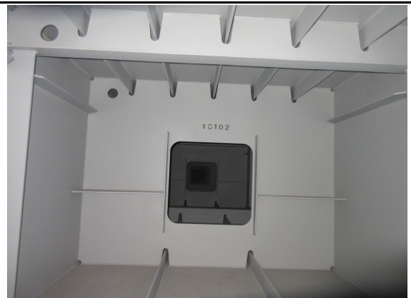
BOX 내부 시공 상태 점검
