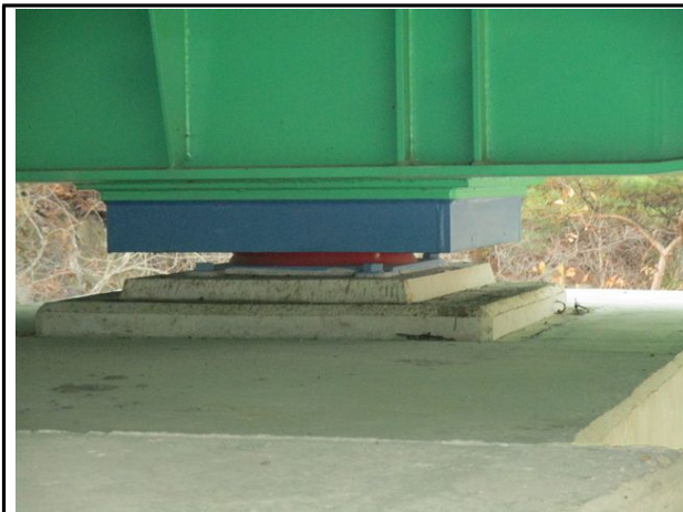
교량받침 P1-SH1 전경
