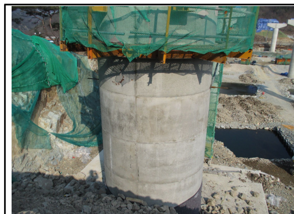
P1 교각 시공 현황
