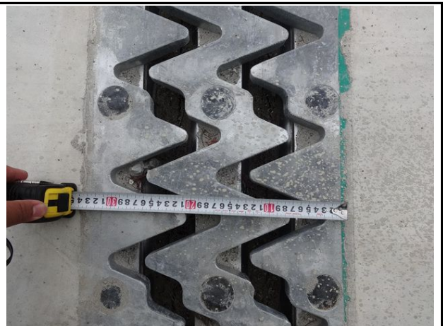
신축이음 A2 유간 측정
