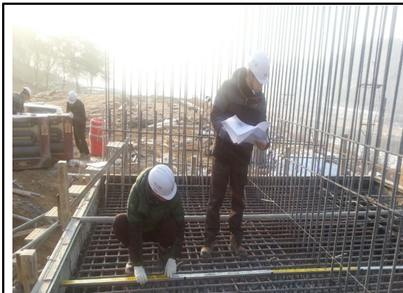
A2 기초 철근 조립 상태
