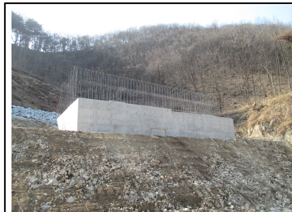
A1 교대 시공 현황
