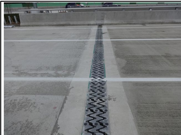
신축이음 A2 전경
