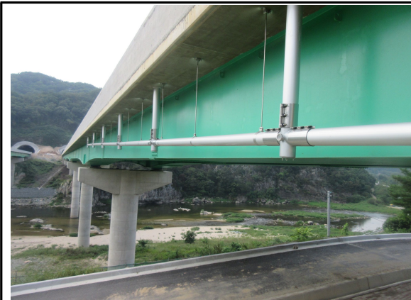
배수관 시공 상태 전경
