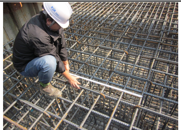
P2 기초 철근 배근 간격
